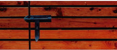
Celosía roble demolición lijado y barnizado
